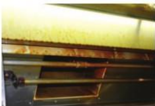
Nelle foto soprastanti un esempio fornito dal produttore di lampade di un sistema VUV utilizzato nella cappa di una friggitrice in una cucina professionale, sinistra prima, a destra dopo 3000 ore di funzionamento VUV.
